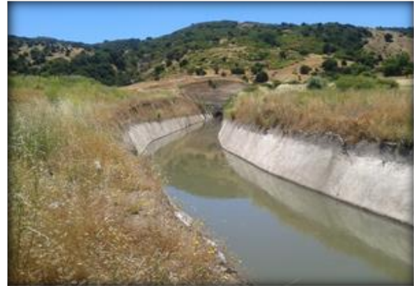
Sector de salida poniente Túnel La Lajuela.
