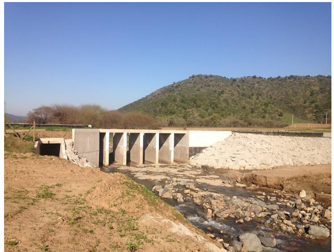
Bocatoma Canal Norte Unificado, barrera frontal.
