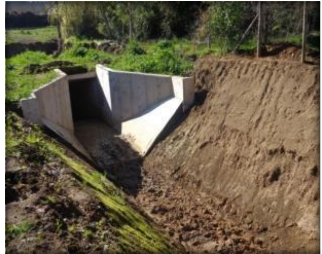
Cámara de salida de Sifón Fortaleza.
